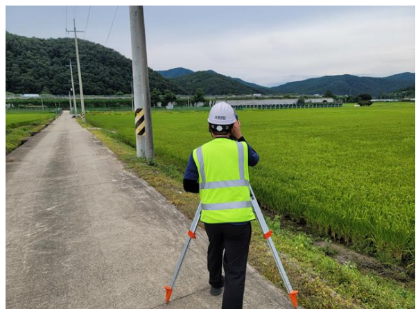
광파기를 이용한 경사도 측정
